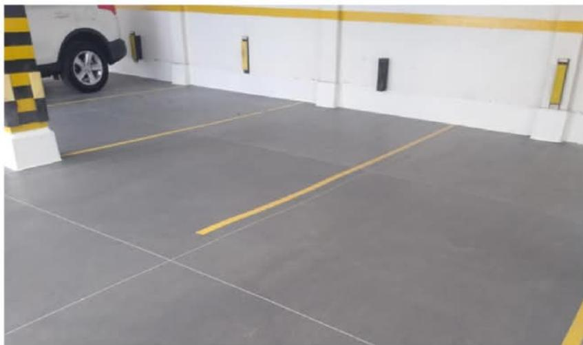
Ele próprio **é o acabamento final**, dispensando a execução de novo contrapiso e piso, e estando disponível em diversas cores e texturas, com vários níveis de antiderrapante.
